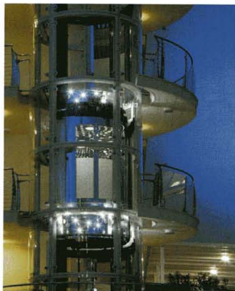
Fig.7 - Una peculiarità degli impianti Special è una migliore organizzazione dello spazio; ciò grazie alla totale assenza del locale macchinario che viene sostituito da un quadro di controllo all'esterno del vano.
